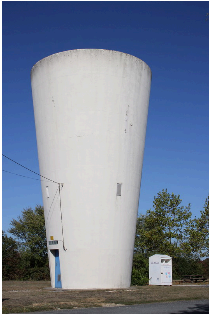
Le château d'eau de la commune, à l'entrée ouest du bourg.
