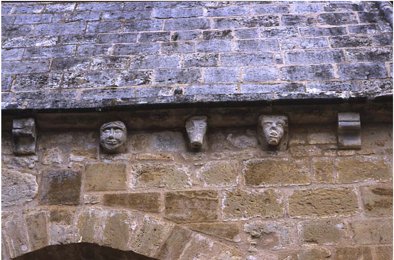
Les modillons de la corniche de l'élévation sud-ouest de l'Octogone.
