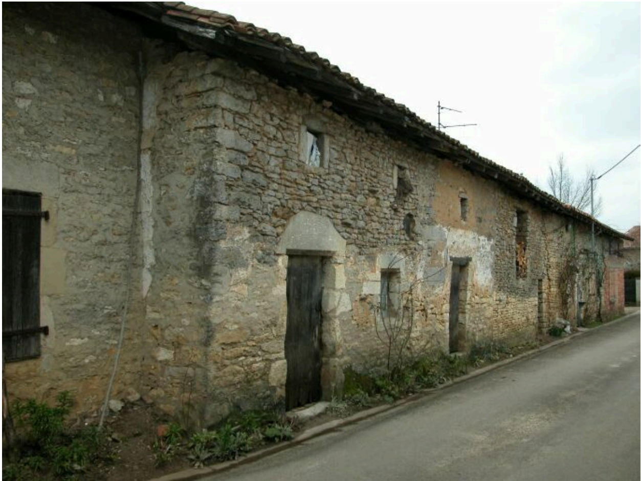
Elévation antérieure de la maison.
