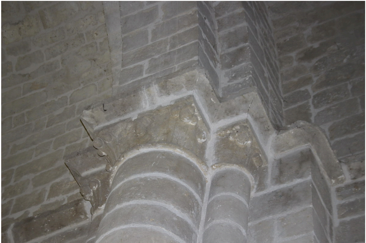
Une vue des châteaux des colonnes du choeur, sur le mur sud.
