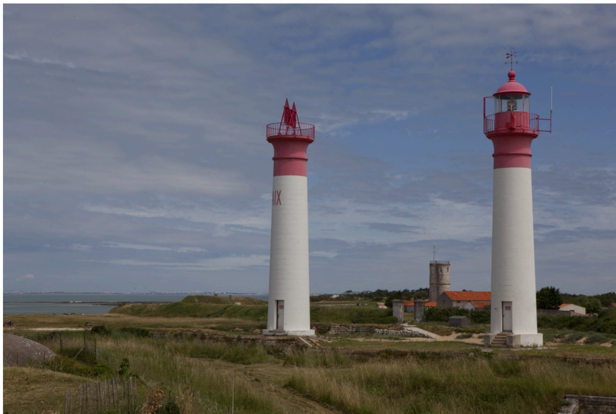
Vue prise du sud-ouest.
