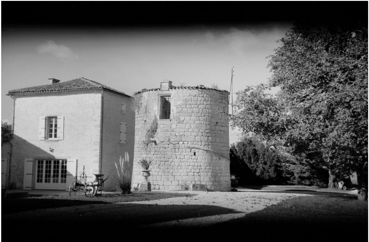
La tour et le corps d'habitation du logis, depuis le sud-est.
