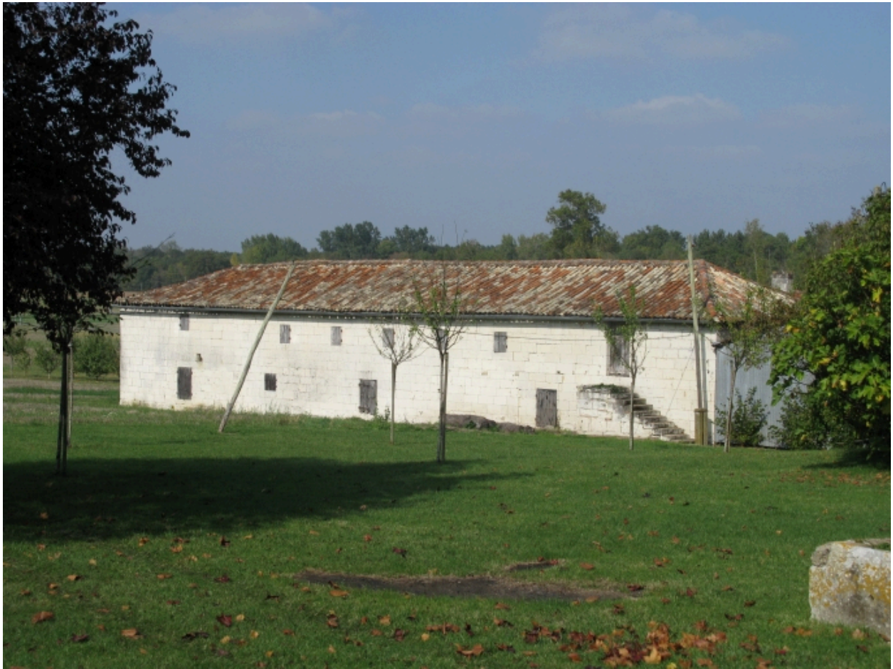
Le chai vu depuis le sud.
