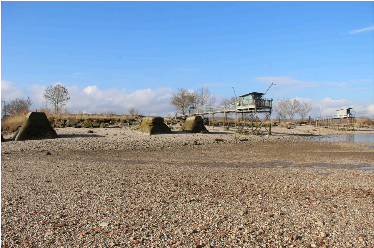
Estran au niveau du chenal du lazaret : blocs d'amarrage de bateaux.
