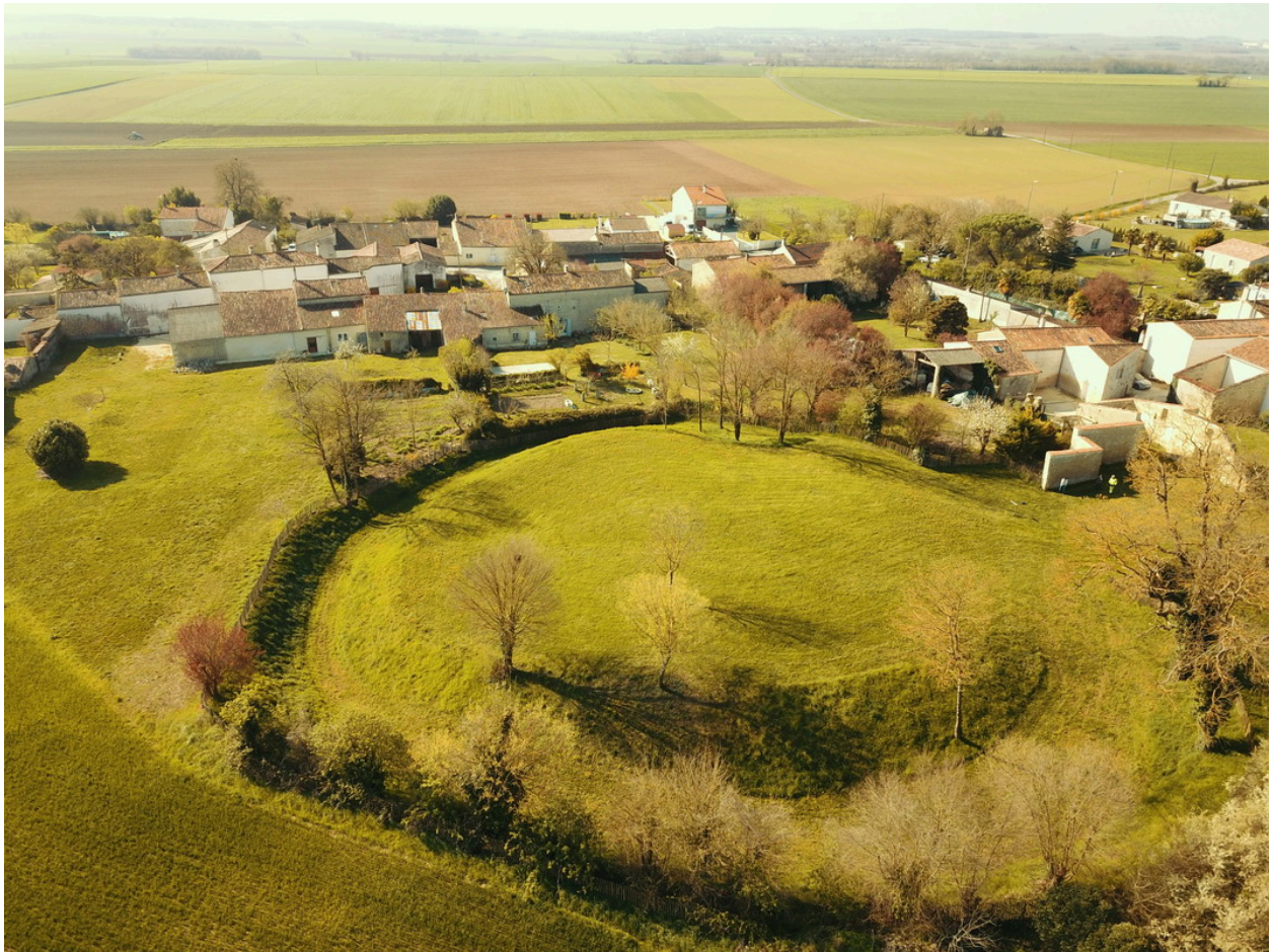
Une vue aérienne du bourg avec au centre la motte féodale.
