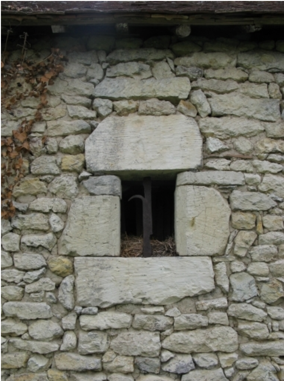
Logement, élévation nord-est, baie à piédroits chanfreinés.
