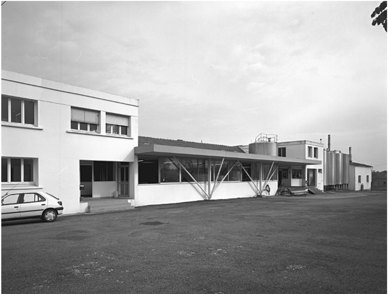
Ancien quai de réception et bureaux vus de l'ouest.
