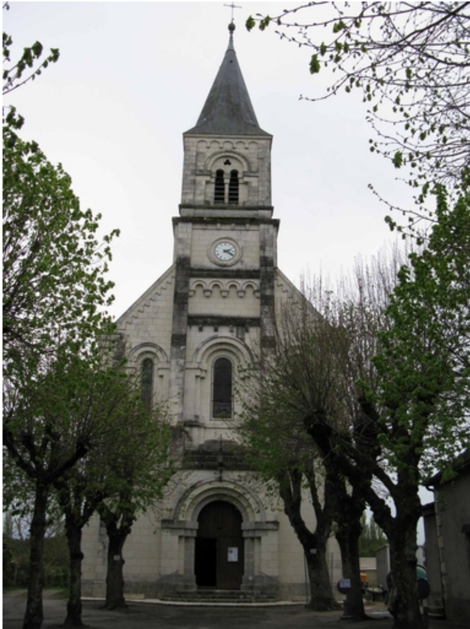
Façade nord de l'église.
