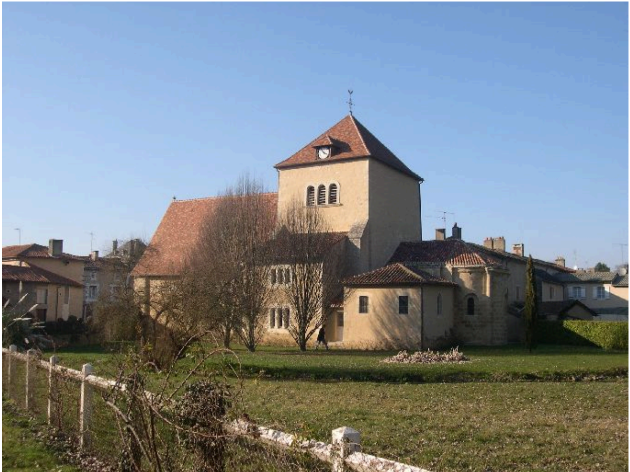
Élévation sud, vue éloignée.
