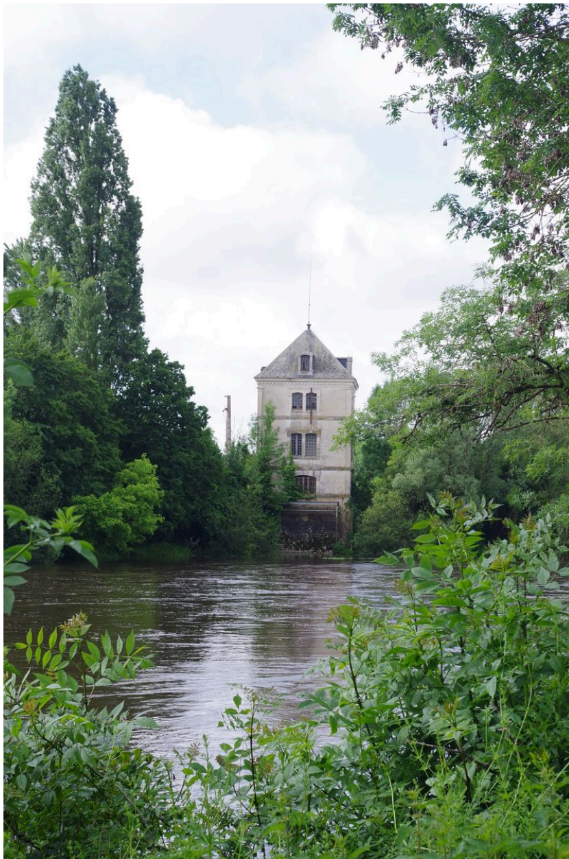
Vue sur le moulin de Villars depuis la cale d'accès au bac.
