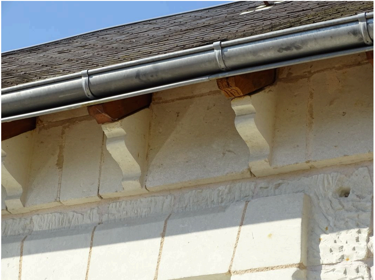
Détail des chevrons et des modillons en pierre de taille de la corniche.
