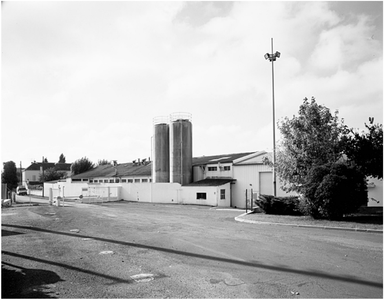
Premier atelier de la biscuiterie vu du nord-ouest.
