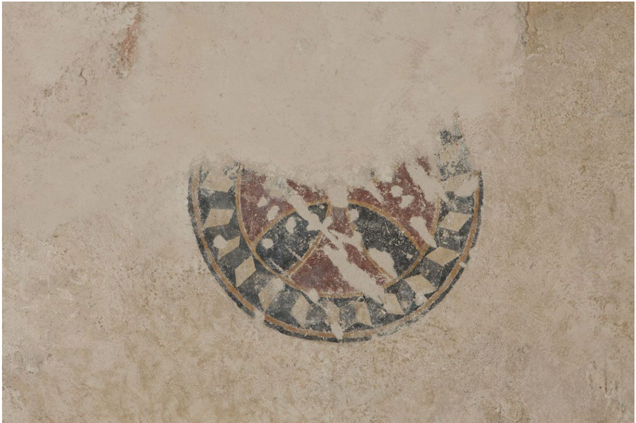
Nef, mur nord, registre inférieur, troisième travée : croix.
