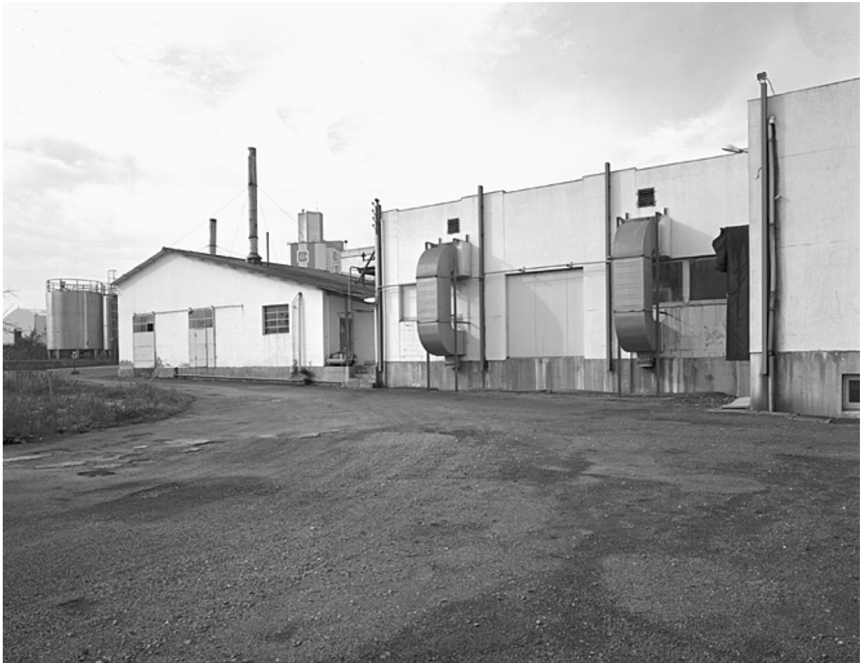
Chaufferie et fromagerie de 1980 vues de l'est.
