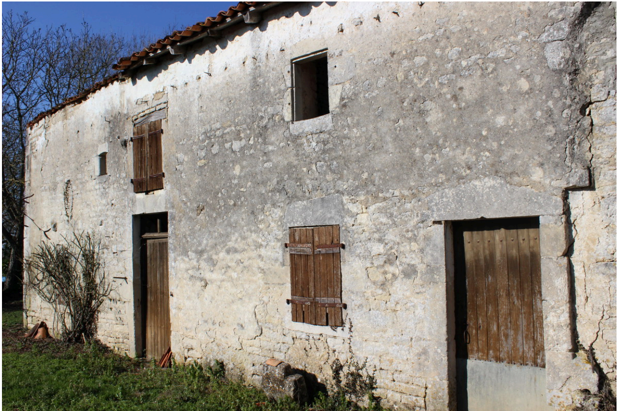
Une vue des deux logements de l'ancienne ferme, depuis le sud-est.
