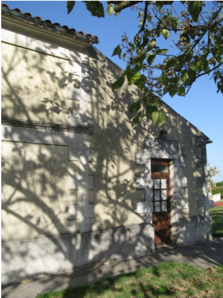
Partie droite de la façade.
