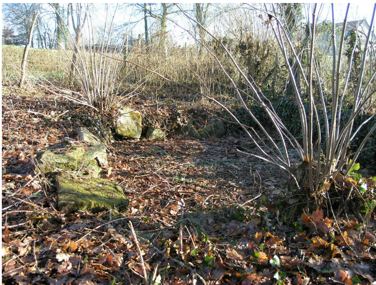
Sagnat, La Sagne - 2008 A non cadastré, domaine public - Vue générale du lavoir.
