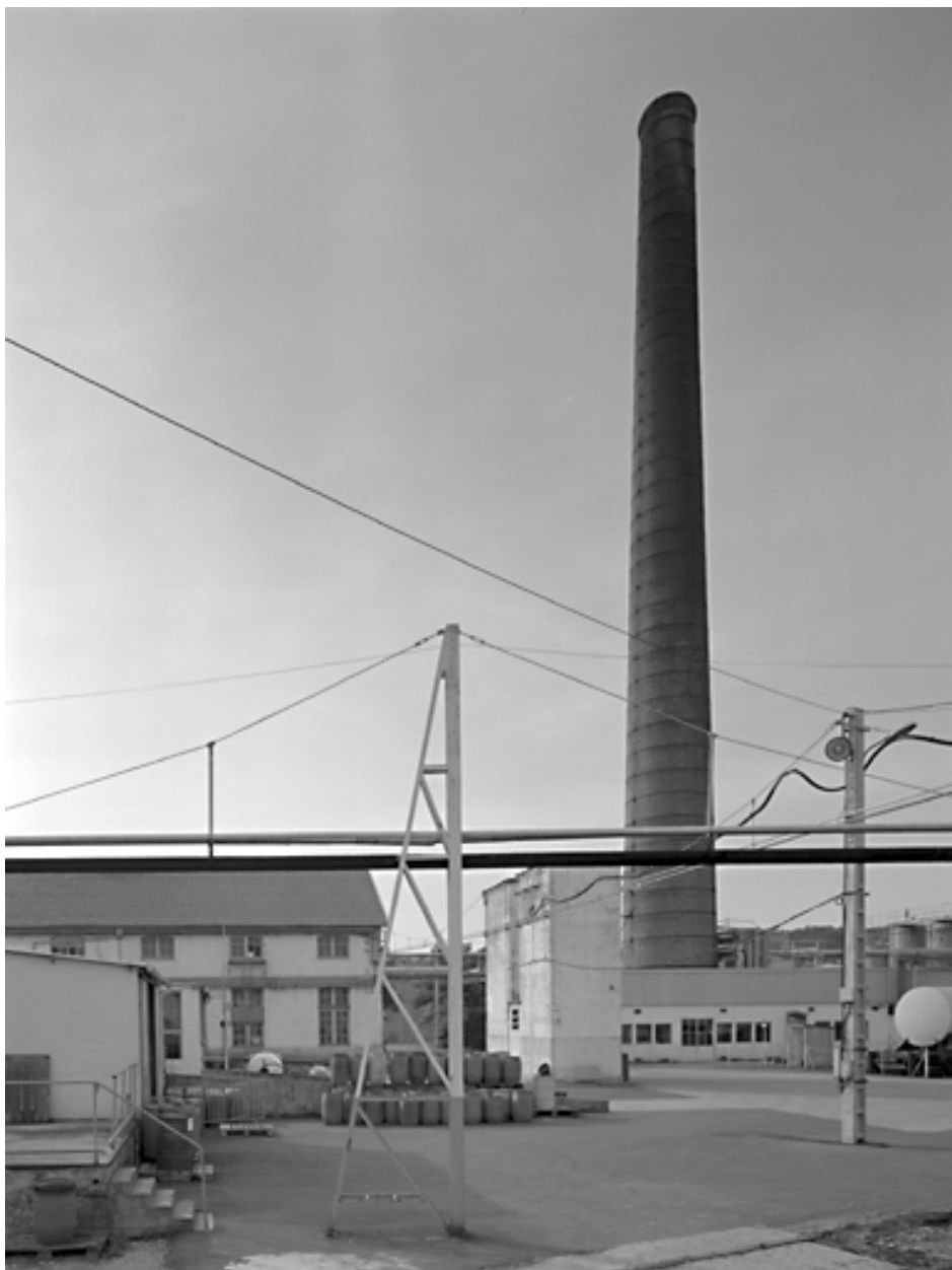
Cheminée de 63m et anciens fours devenus transformateurs vus depuis l'est.
