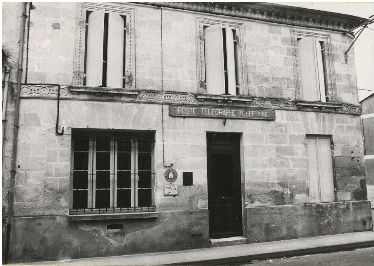
Vue d'ensemble : état en 1974.
