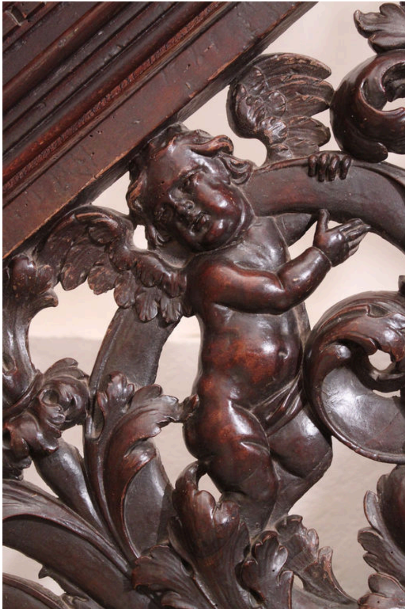
Détail de la rampe de l'escalier (ange).
