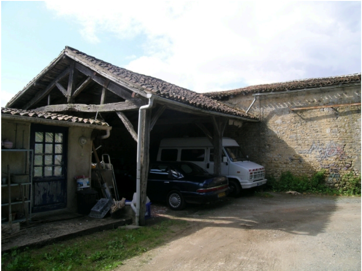
Le hangar perpendiculaire à la grange, vu du nord.
