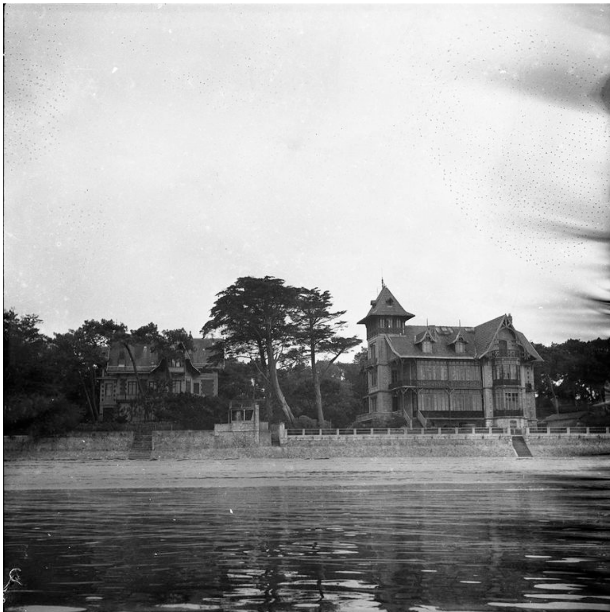
Ensemble depuis la plage (état en 1987).
