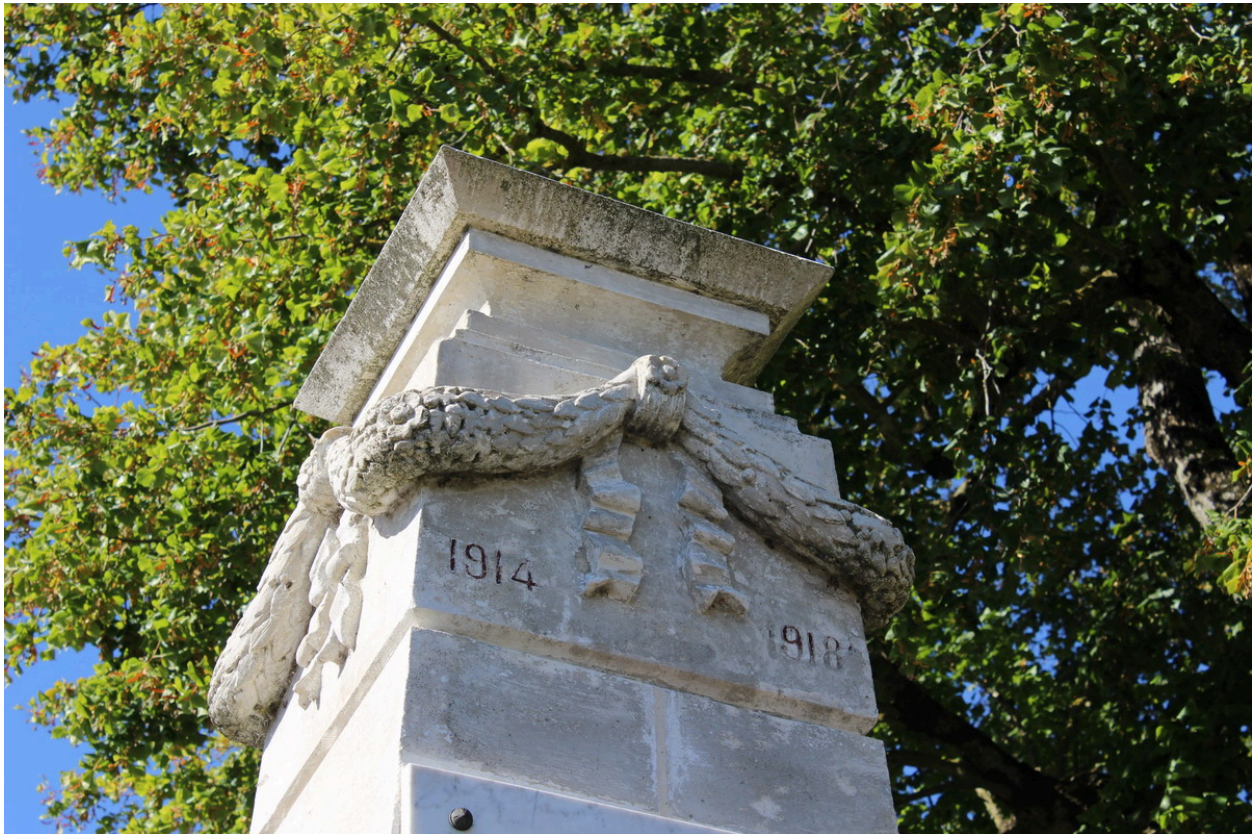
Un détail du sommet de la colonne, depuis le nord-est.
