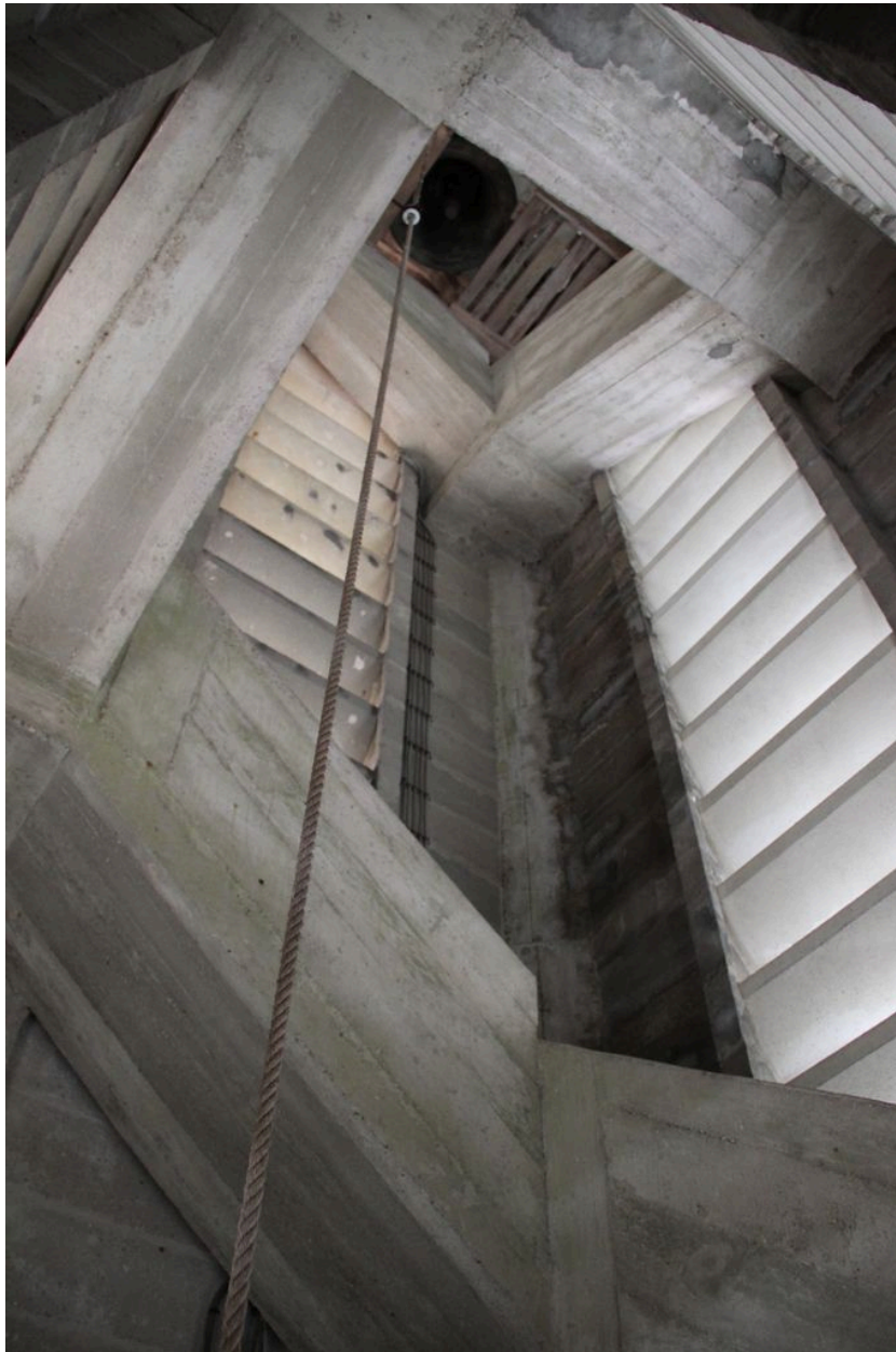
Clocher : vue intérieure de la structure en béton.
