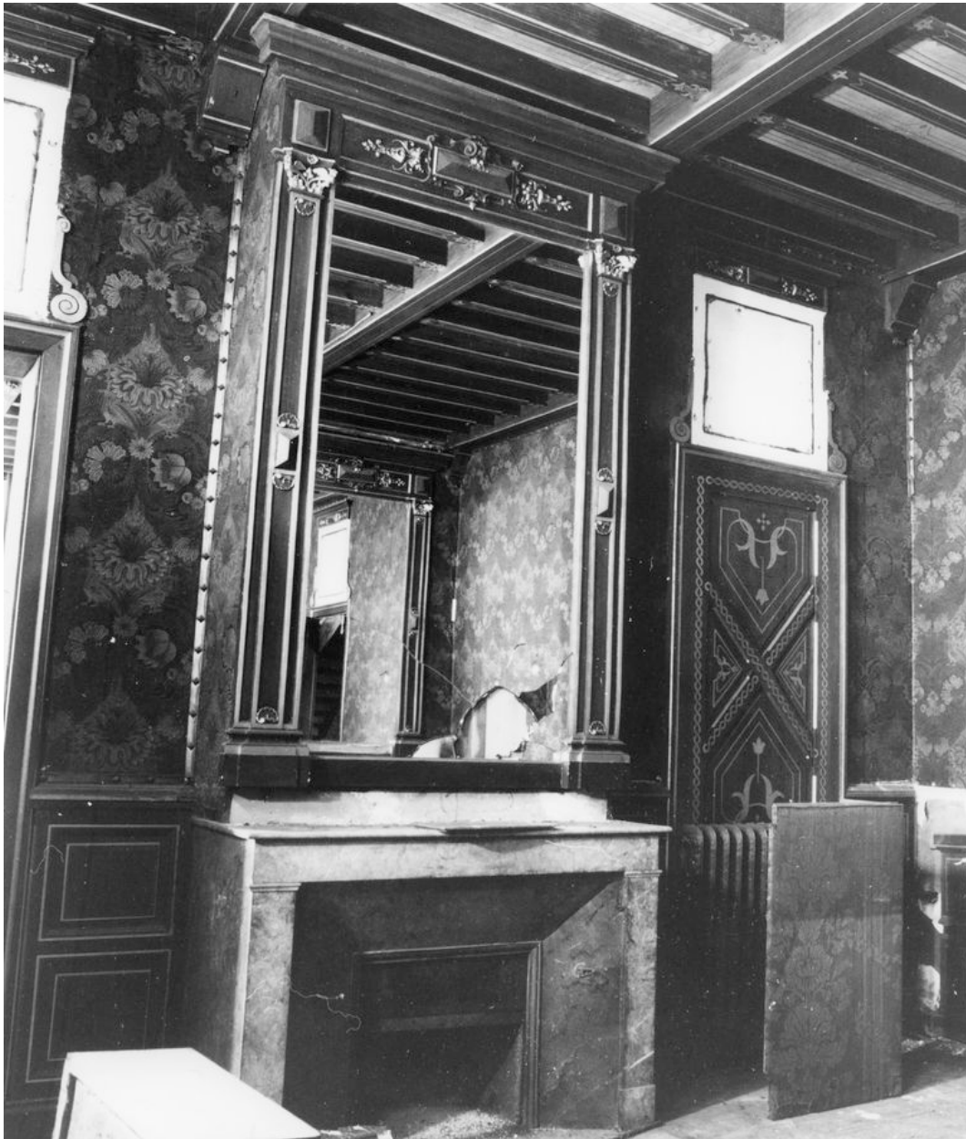
Etage carré. Chambre (n°6 du plan). Mur Est avec cheminée (état en 1977).
