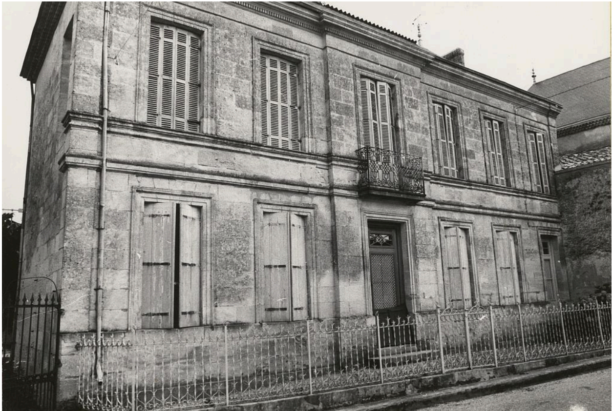
Vue d'ensemble : état en 1974.
