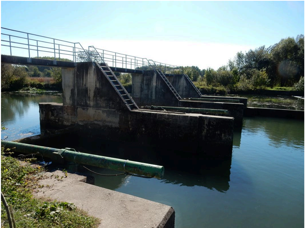
Les vannes du côté aval.
