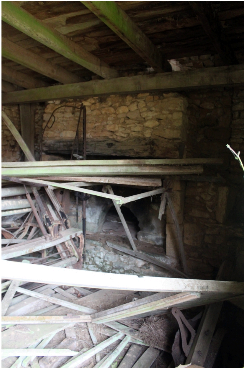
Vue intérieure du logis de la ferme : cheminée dotée d'un four à pain.
