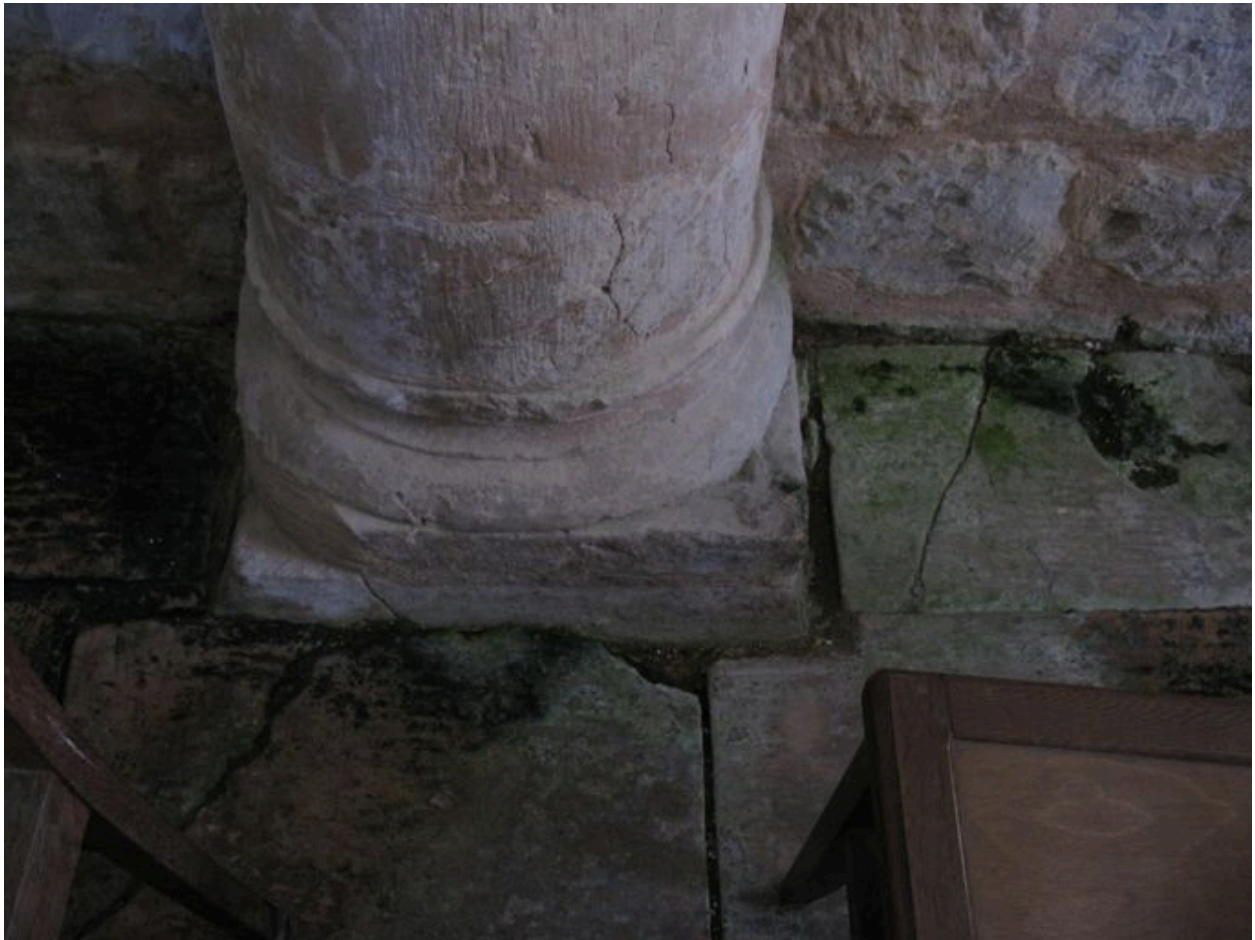
Nef, mur sud, deuxième colonne engagée : base.
