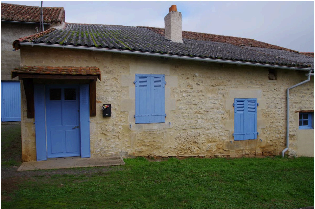
Vue de la façade sud de la maison.
