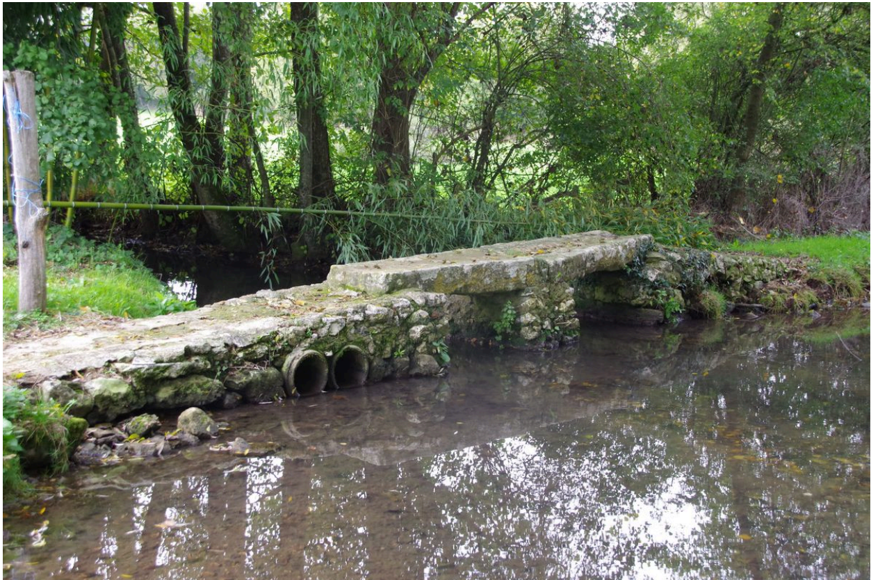
Point de jonction entre le bief de dérivation et le ruisseau de Goberté.
