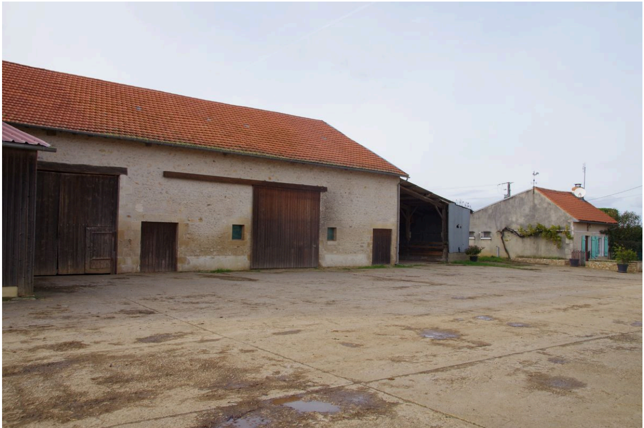
Vue de la grange, façade est.
