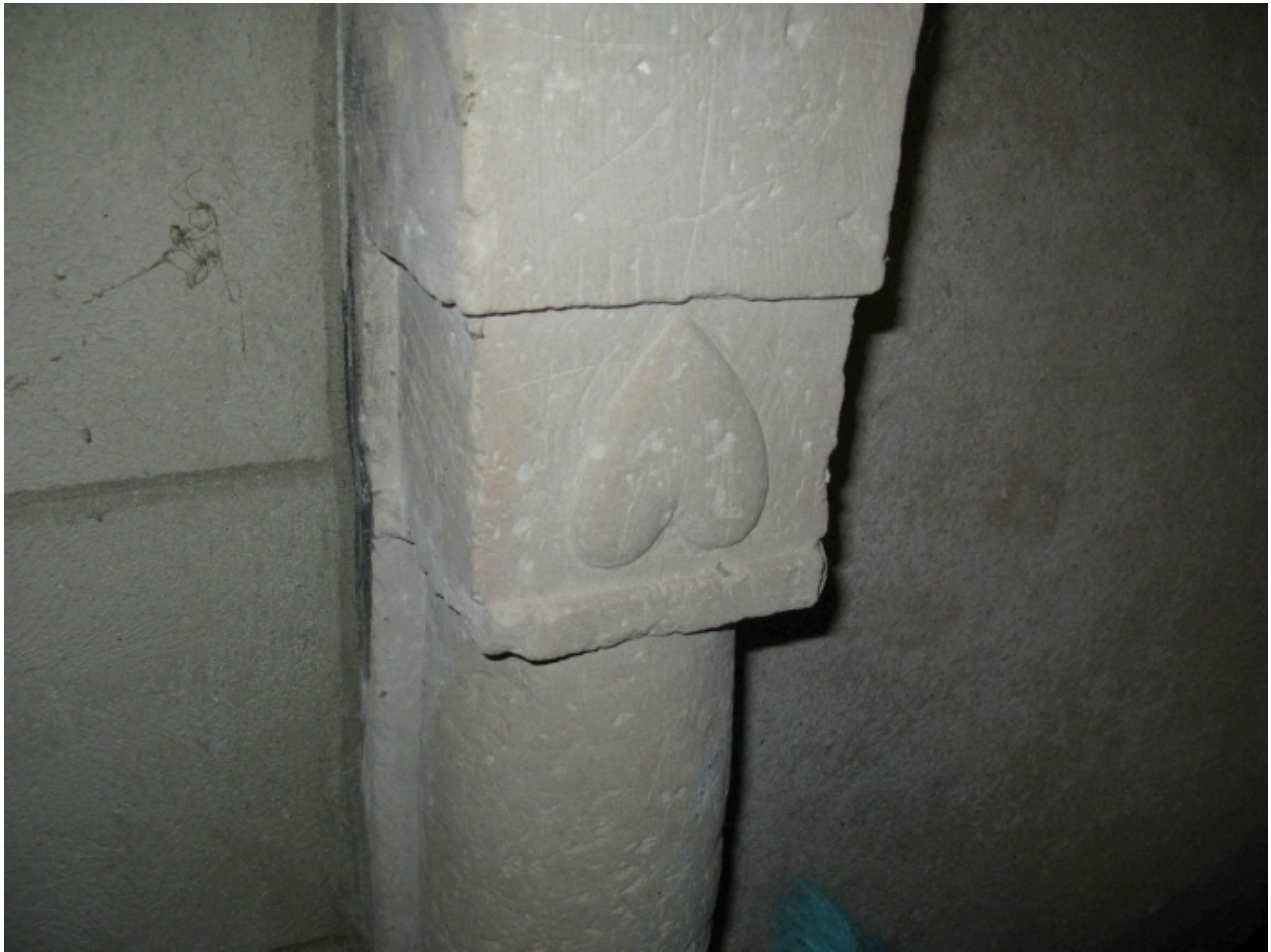
Ancien logement, cheminée, détail.
