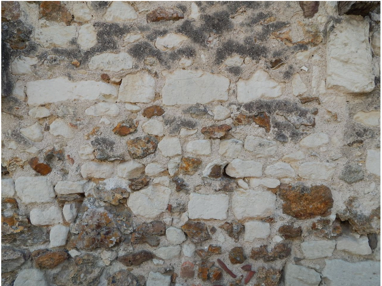
Maçonnerie de caicaire et de silex.
