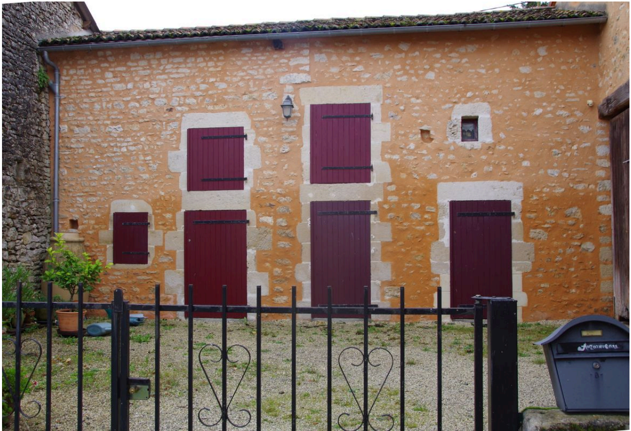
Vue de l'ancienne dépendance transformée en logement.
