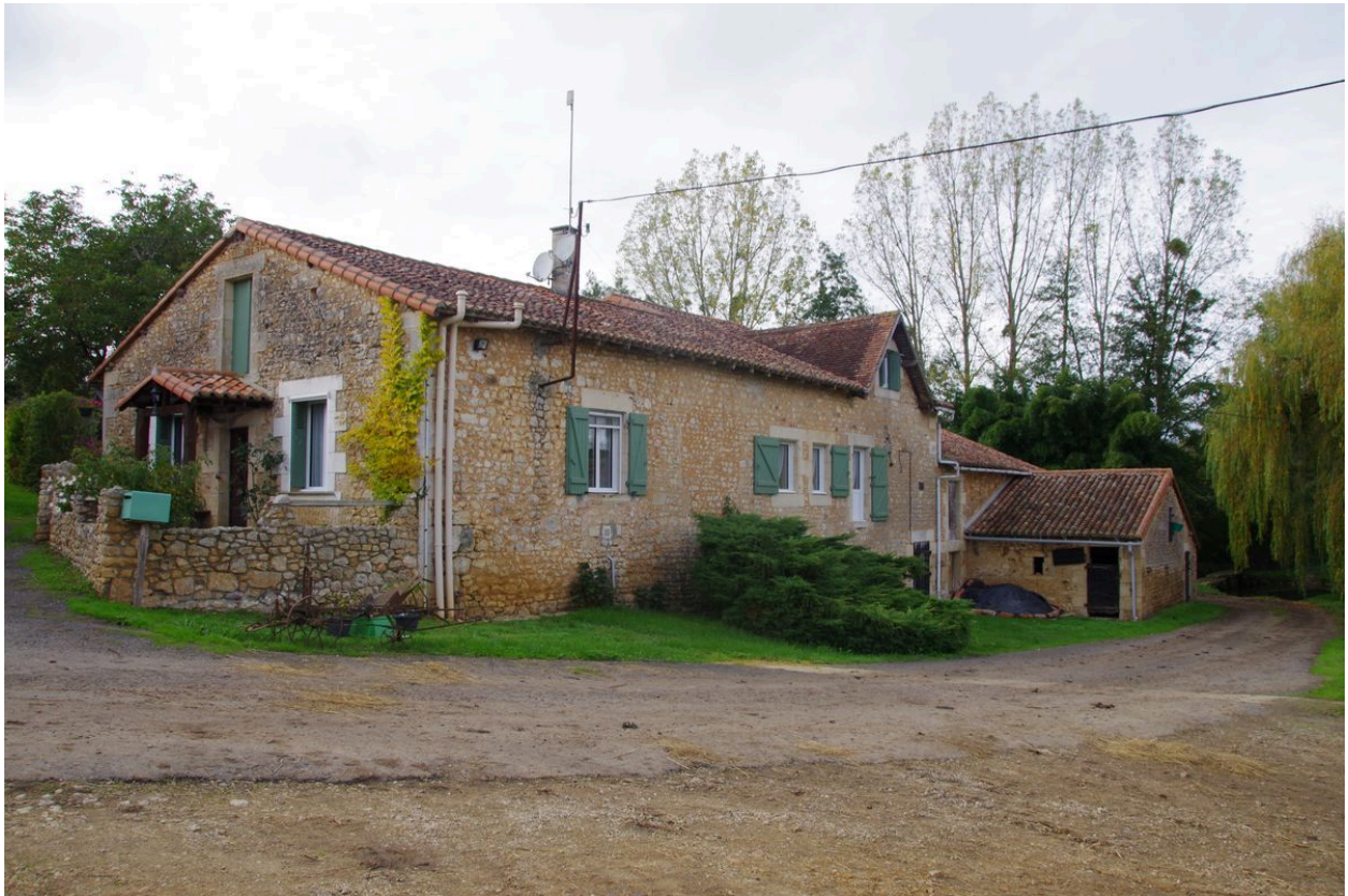
Vue d'ensemble depuis le chemin d'accès, pignon sud et façade est.
