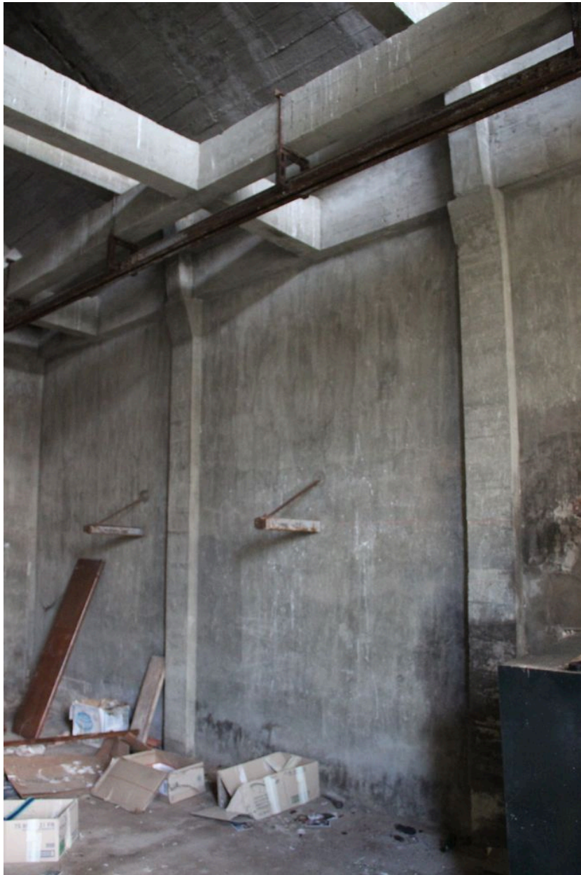
Vue intérieure : détail des piliers engagés soutenant la charpente en béton.
