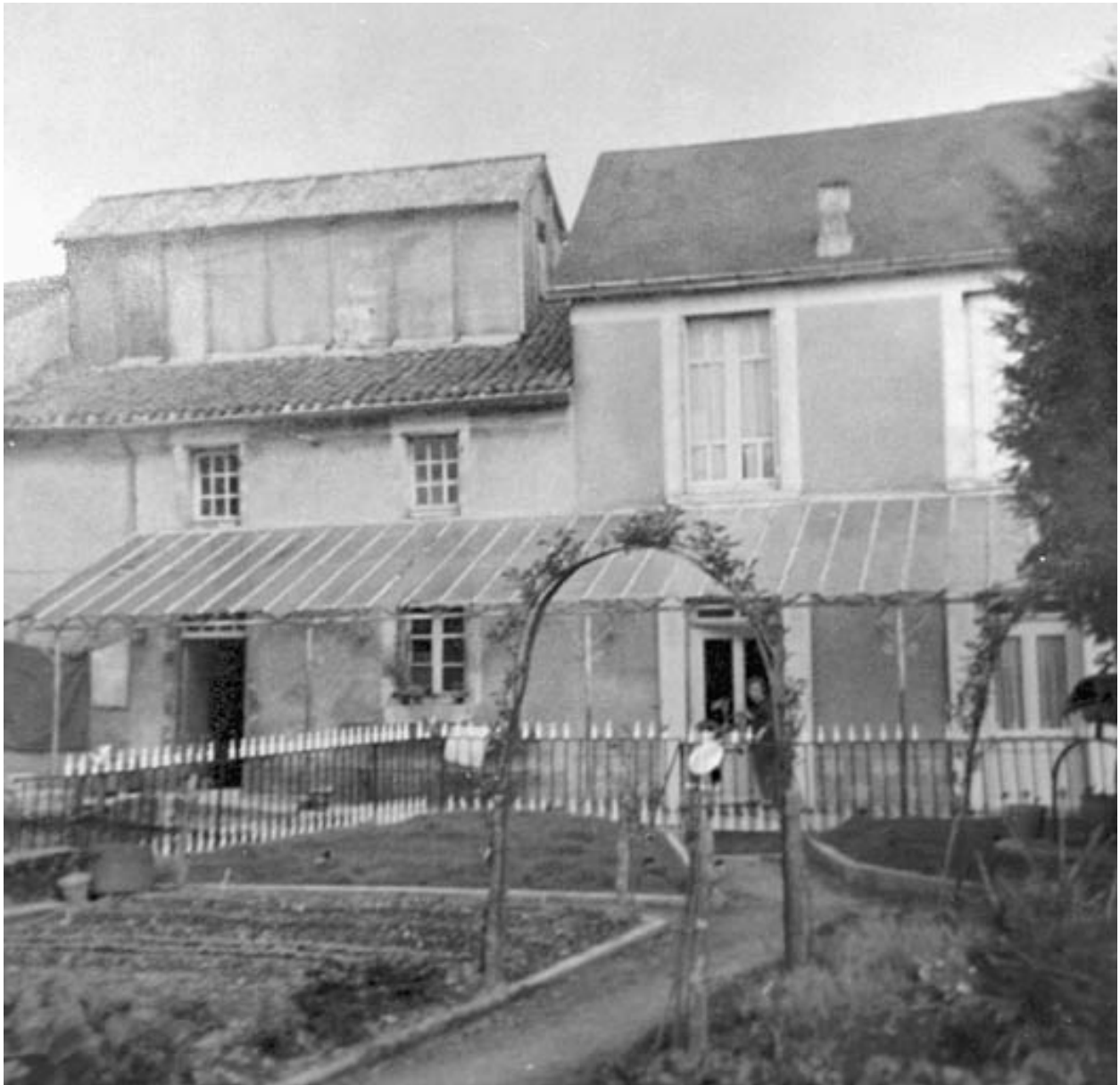
Logement et minoterie (avec sa surélévation) vus du sud-est.
