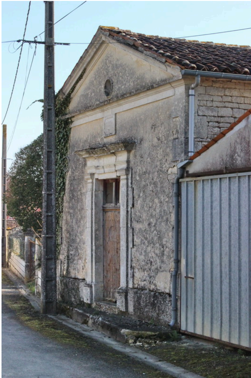
La façade sur rue du temple, depuis le nord-ouest.
