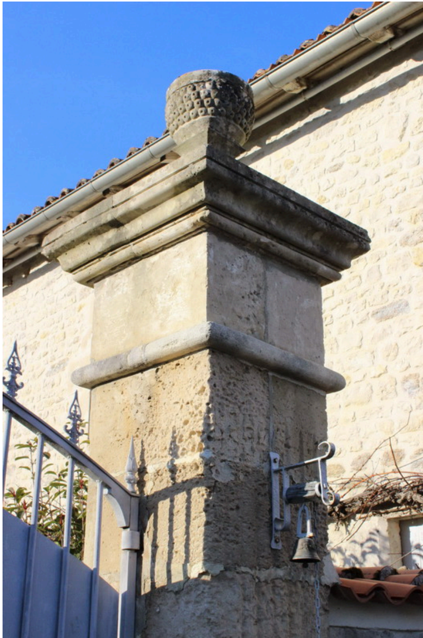
Un détail d'un pilier du portail, depuis le sud-est.
