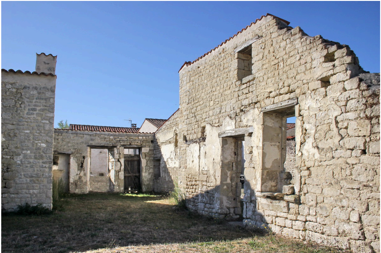
Une vue des murs intérieurs des vestiges de constructions à proximité de la motte féodale.
