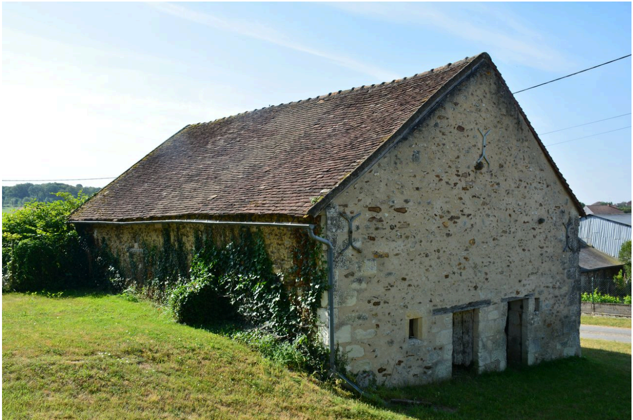
Élévation ouest de la grange.
