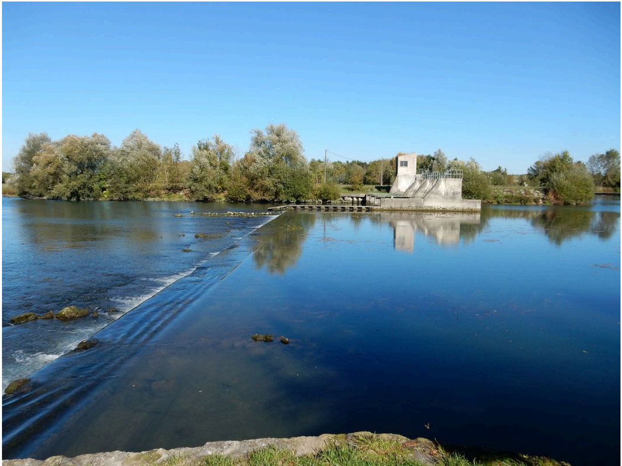
Vue prise du sud, avec le déversoir au premier plan.
