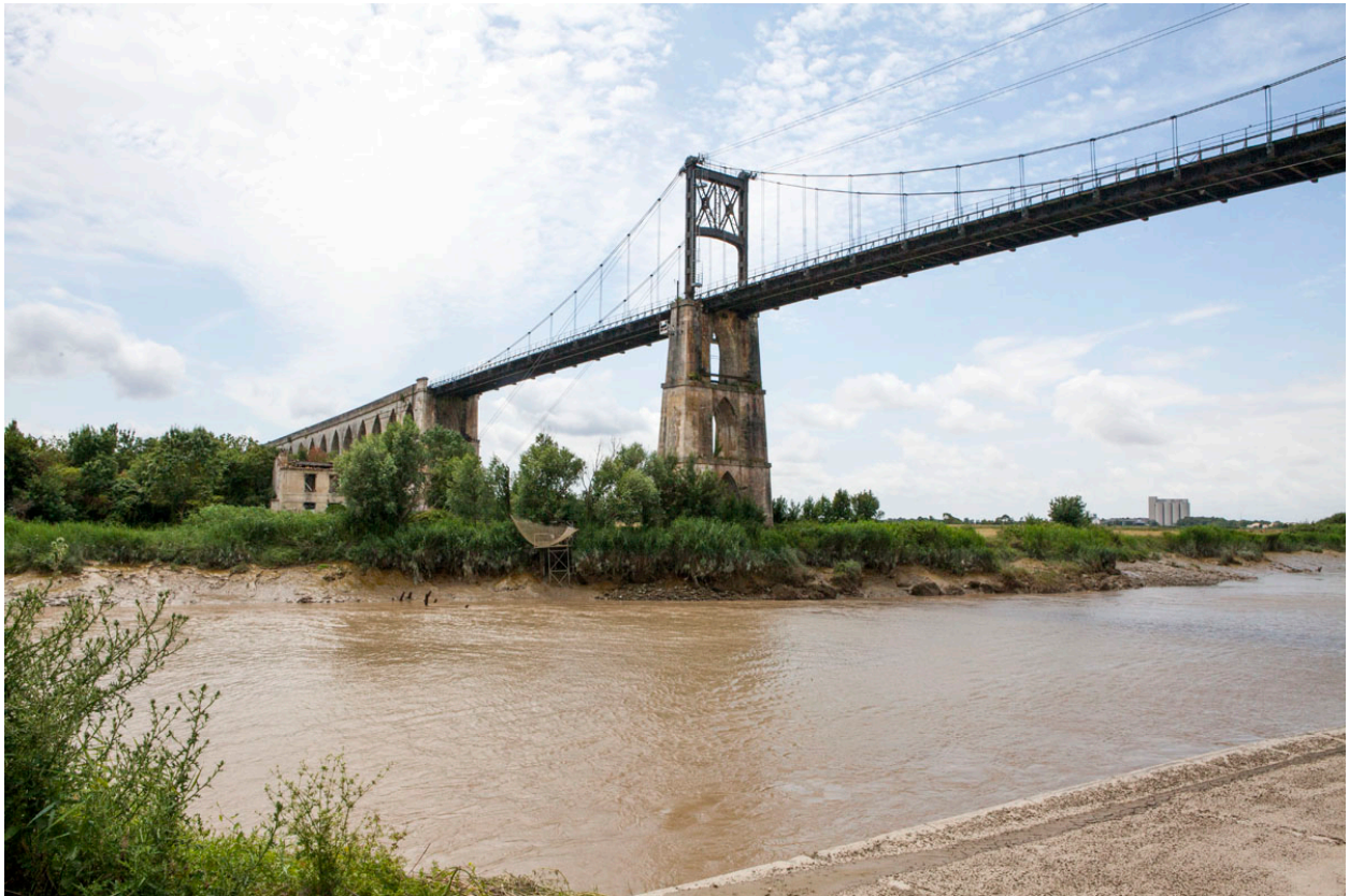
Pont vu du nord-est, depuis la rive droite, à marée haute.
