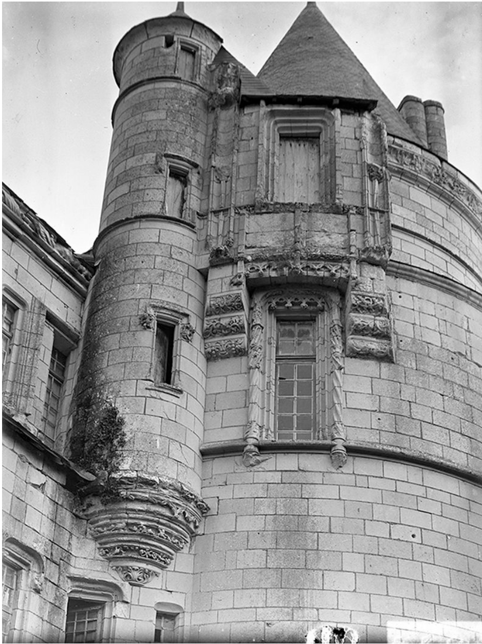
Détail de l'échaugette située dans l'angle nord de la tour.
