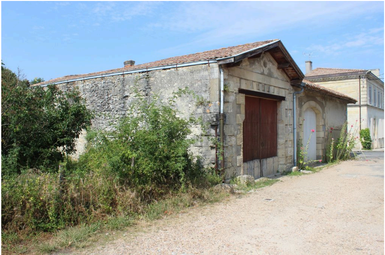
Rue des 4 Vents : dépendances (parcelle 1265).
